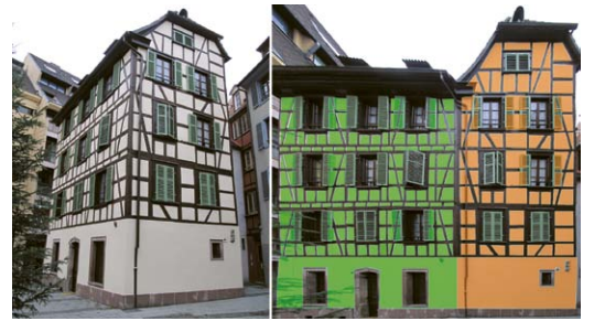
Ci-dessus, à gauche : photo originale. À droite : photo redressée avec développé du bâtiment et relevé des surfaces d'enduit (en vert et orange).
